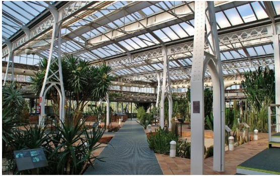
Antigua "Nave de las Patatas" rehabilitada como INVERNADERO PALACIO DE CRISTAL
