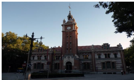
CASA DEL RELOJ (Centro Cultural y Junta Municipal del Distrito de Arganzuela)
